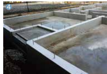
立ち上がり部分の枠組みを施工し、コンクリートを流し養生させれば基礎が完成です
