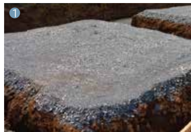
割栗石・砕石を敷き転圧をかけ固めます
